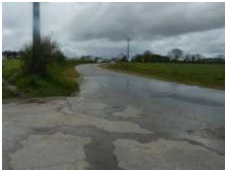
Un effluent nauséabond sort des bouches d'égout
