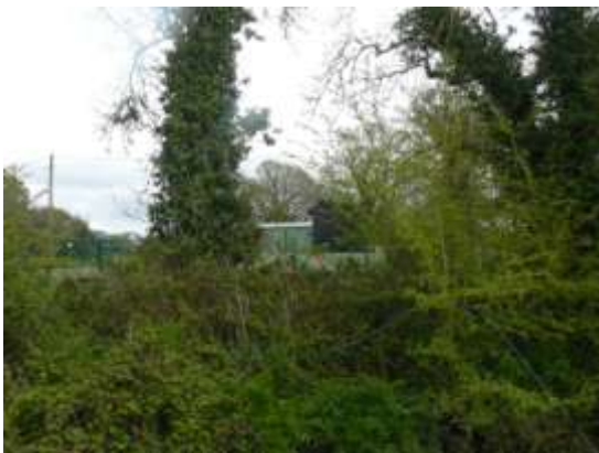
La station de relevage rénovée en 2010 a été saturée
